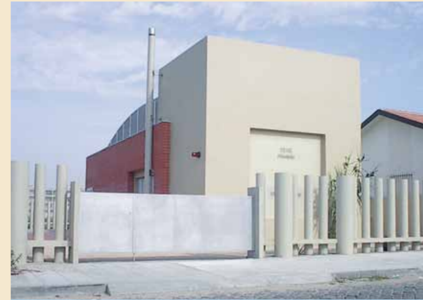
Estação Elevatória da Rua de Oslo
