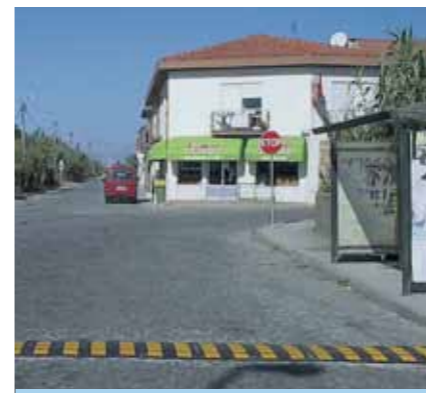
Colocação de Bandas Sonoras
