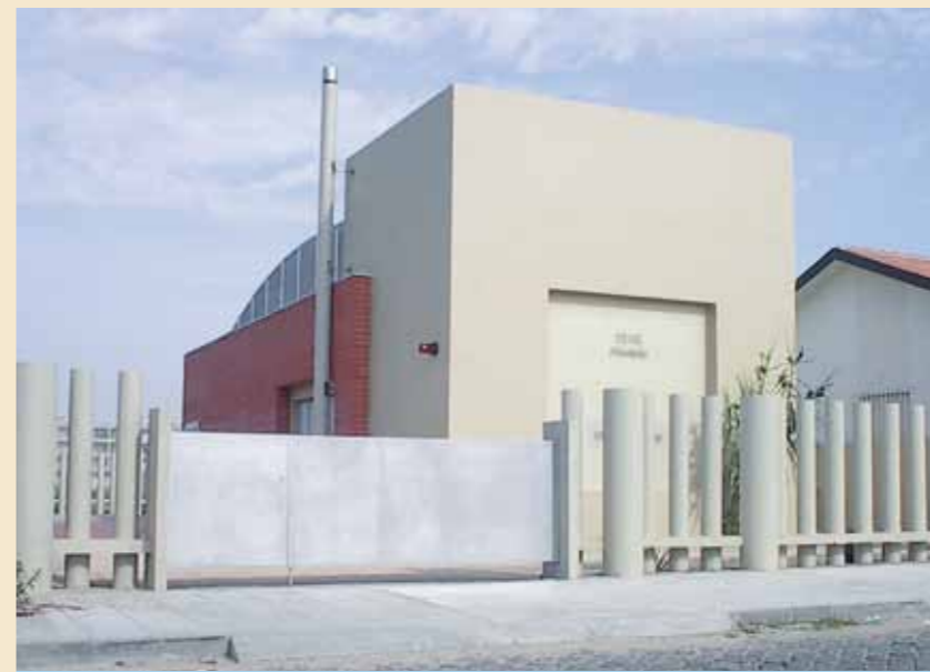
Estação Elevatória da Rua de Oslo
